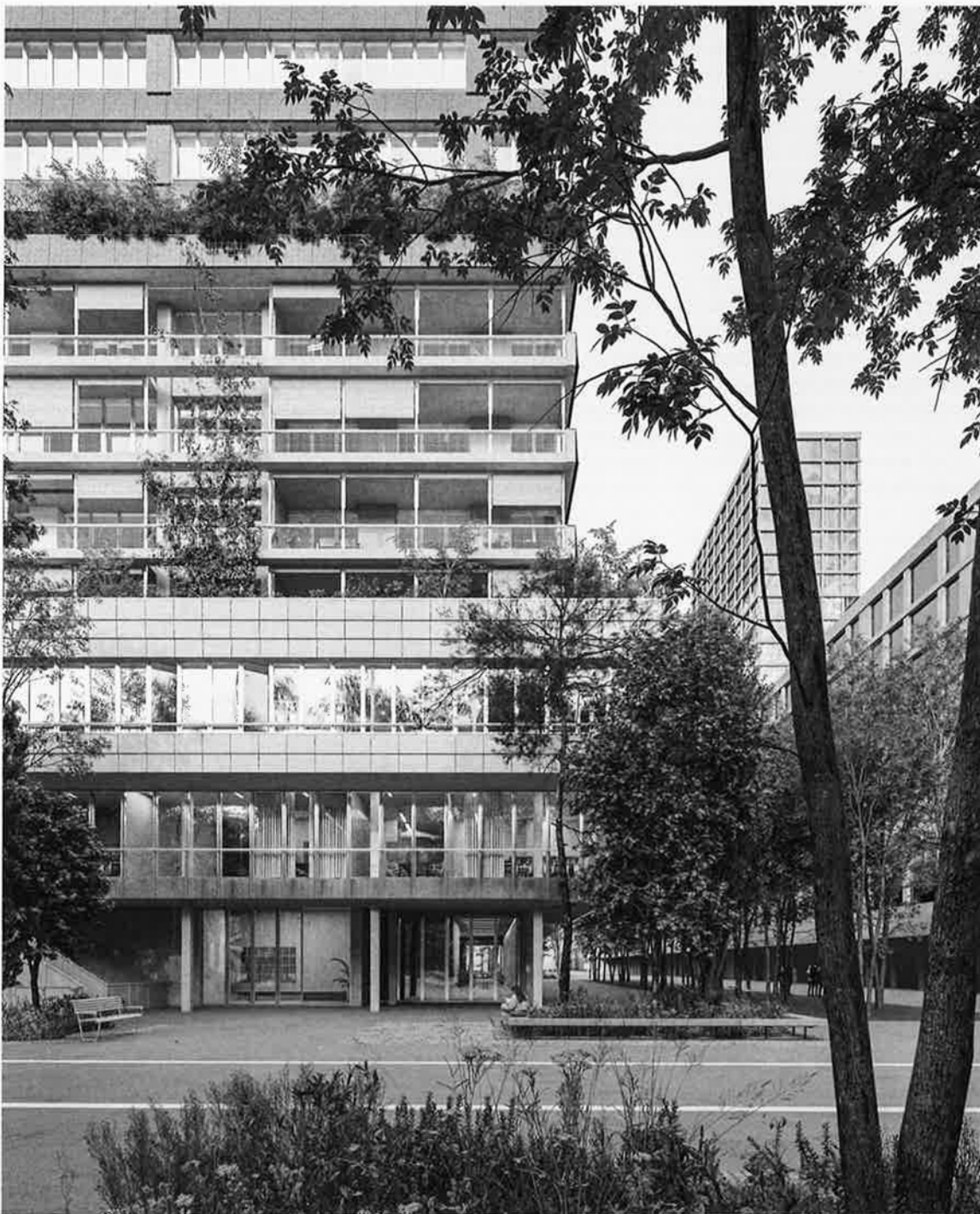
Der siegreiche Entwurf von op-arch für das Neue Zentrum Dorfmatte arbeitet mit wiederverwendeten Natursteinplatten an der Fassade. Bild: Indivisual
