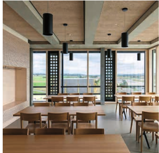
Der Beton des Rohbaus ist teilweise sichtbar. Der Bodenbelag ist ein geschliffener Anhydritestrich. Für Raumtrennungen, Innentüren und Akustikverkleidungen verwendeten die Beteiligten Holz.
