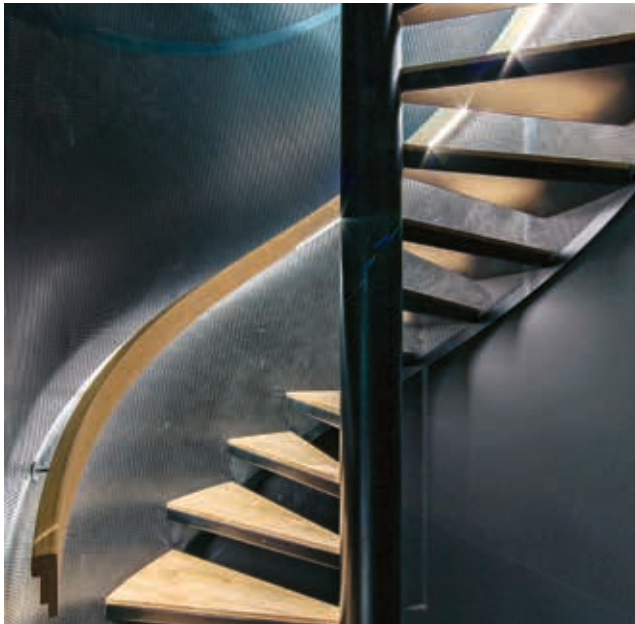
Die von einer Stahlwange gefasste Spindeltreppe führt zur Kontrollkanzel auf der Auskragung.
