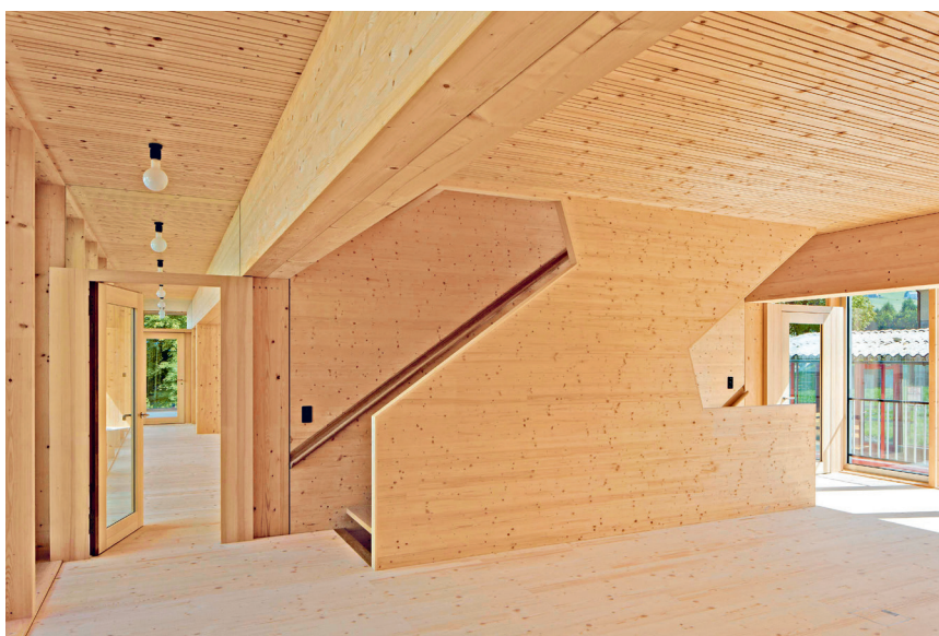
Hölziges Innenleben mit Vollholzwänden aus der Produktion «Appenzellerholz». Im gesamten Gebäude wurde ausschliesslich Schweizer Holz verbaut.
