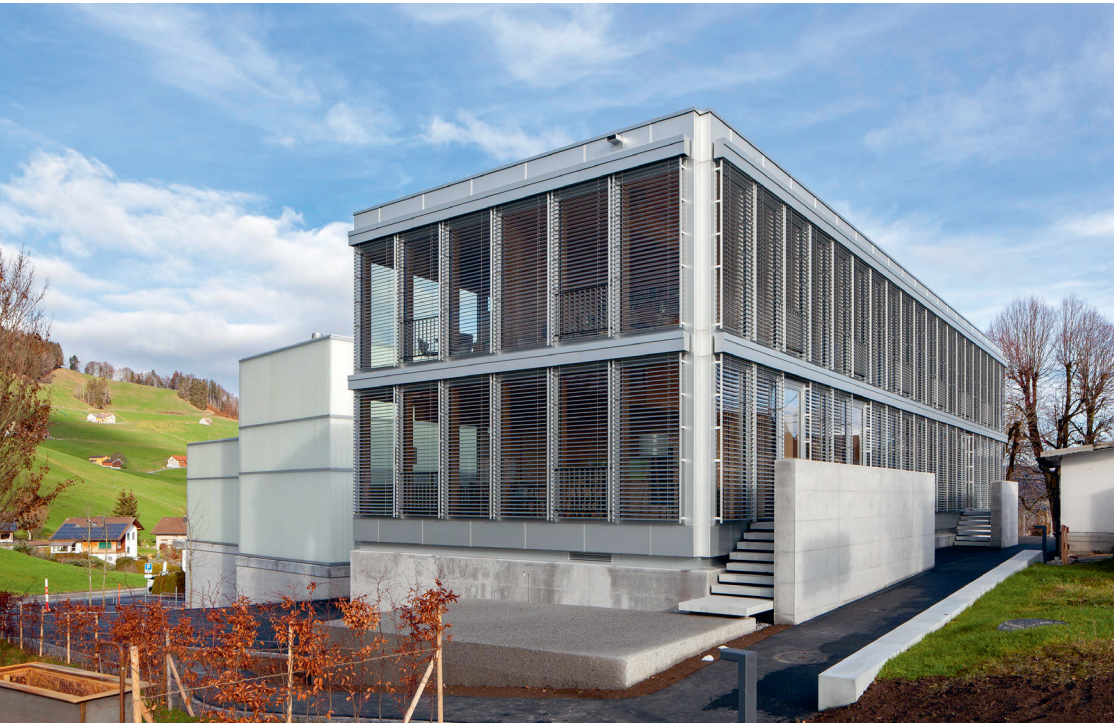
Das neue Bürogebäude liegt eingebettet in die hügelige Landschaft des Appenzell. Links, hinter der milchig weissen Profilglasfassade, befindet sich der erweiterte Produktionsbereich.
