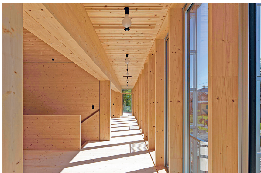
Die Tragstruktur des Holzskelettbaus ist im Innern sichtbar. Die Erschliessung der Büroräume erfolgt entlang der Fassade.
