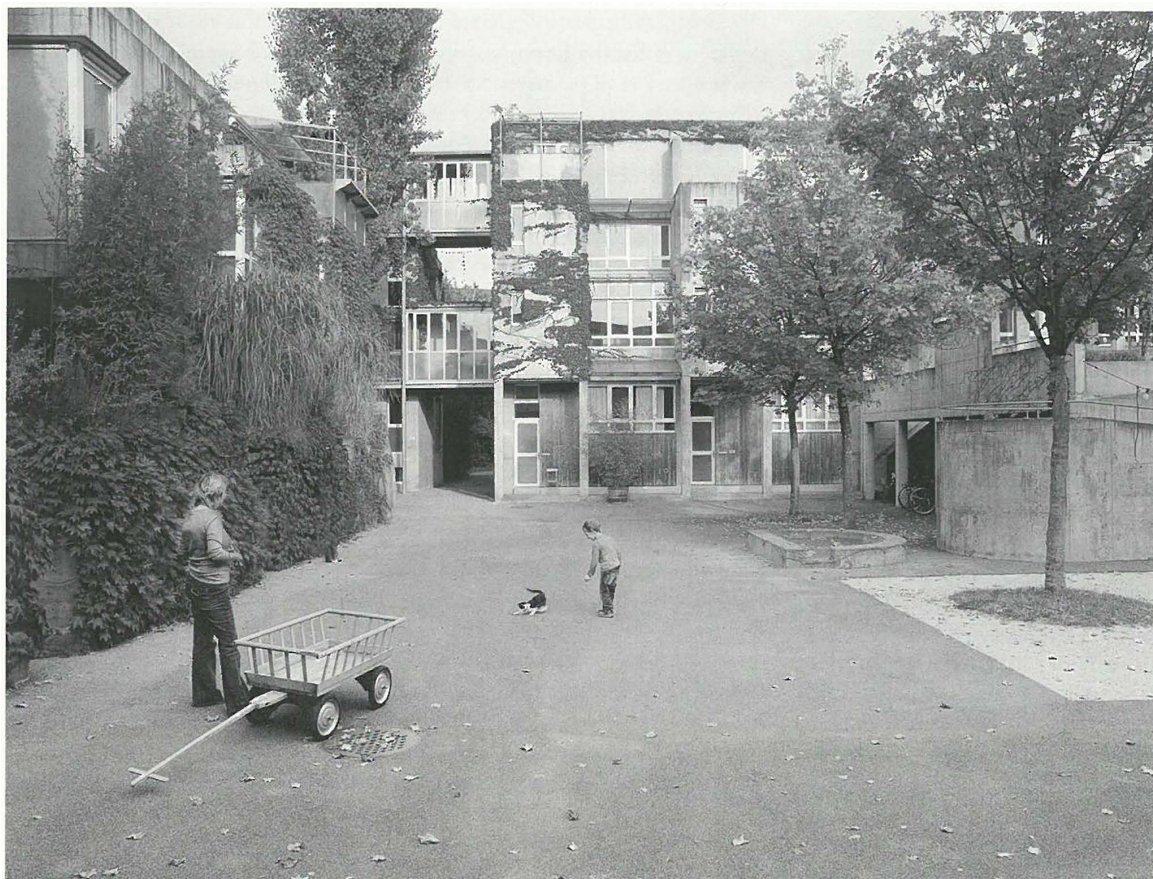
Siedlung Ried W2 von Atelier 5 in Niederwangen bei Bern, 1990. Die relativ dicht beieinander stehenden Baukörper erlauben gefasste und kommunikative Zwischenräume und erfreuen sich einer hohen Akzeptanz. Bild: Yoshiko Kusano
